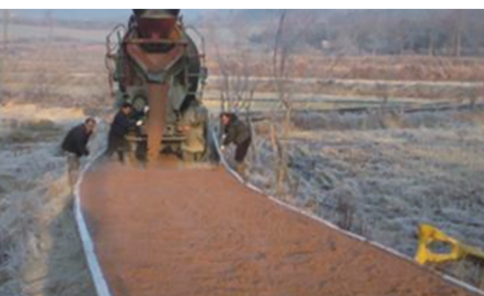
▲그림 4 흙콘크리트로 도로포장하는 모습
